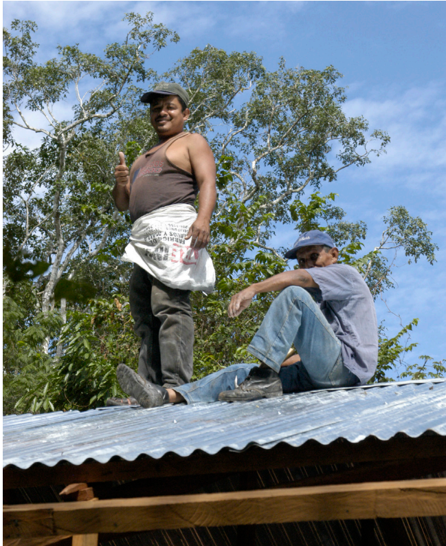
Trabajadores oriundos de la Aldea Uaxactun esperan sus herramientas, para continuar construyendo el techo de la cocina.
