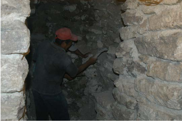
Fig.1. proceso de consolidación circuito de visita cuarto de las pinturas. ventana 4 o norte.
