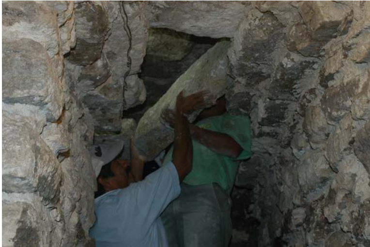
Fig.2. Proceso de consolidación del túnel y Bóveda
