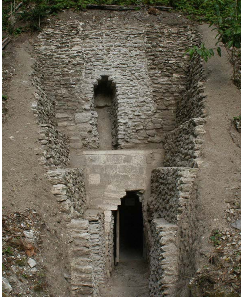
Fig.6. Consolidación de muros laterales de la entrada principal del túnel que conduce a Sub. 1ª.
