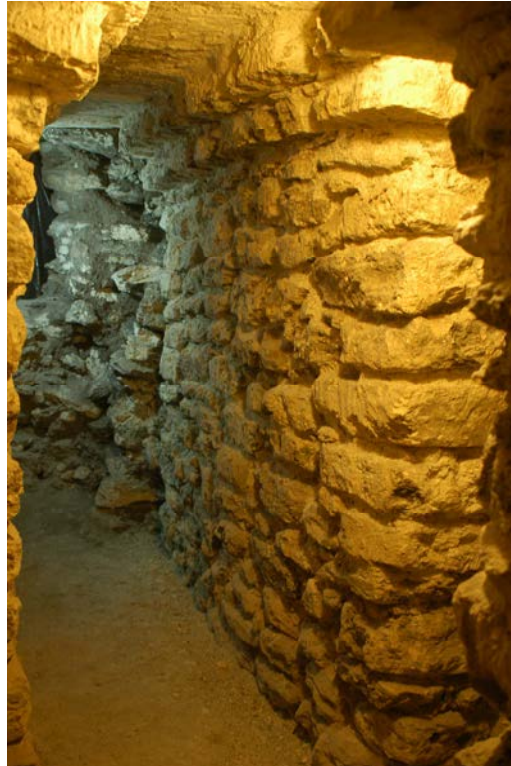
Fig.1. Consolidación del Túnel de las Pinturas circuito de visita.
