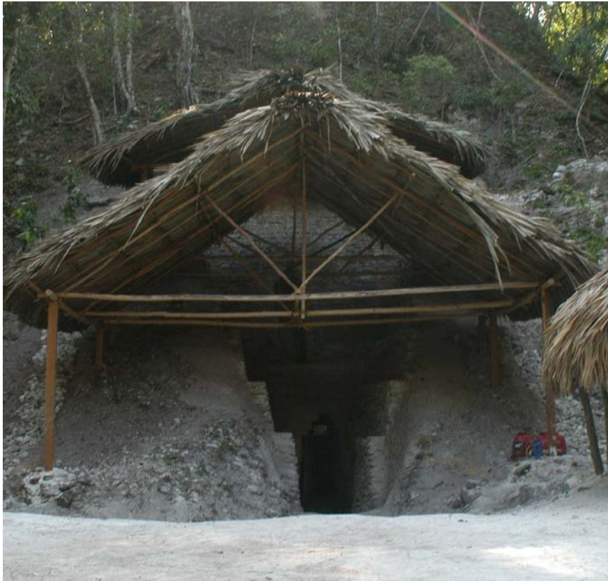
Fig.11 Cubierta de protección entrada principal de acceso a sub -
