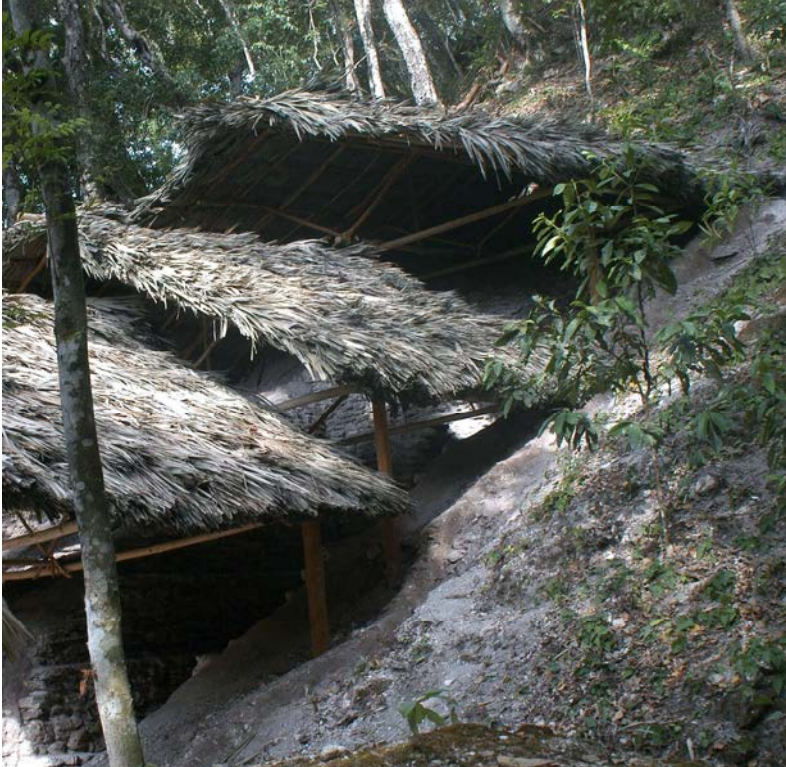
Fig.14 Sistema de protección del túnel de entrada al cuarto del as pinturas.
