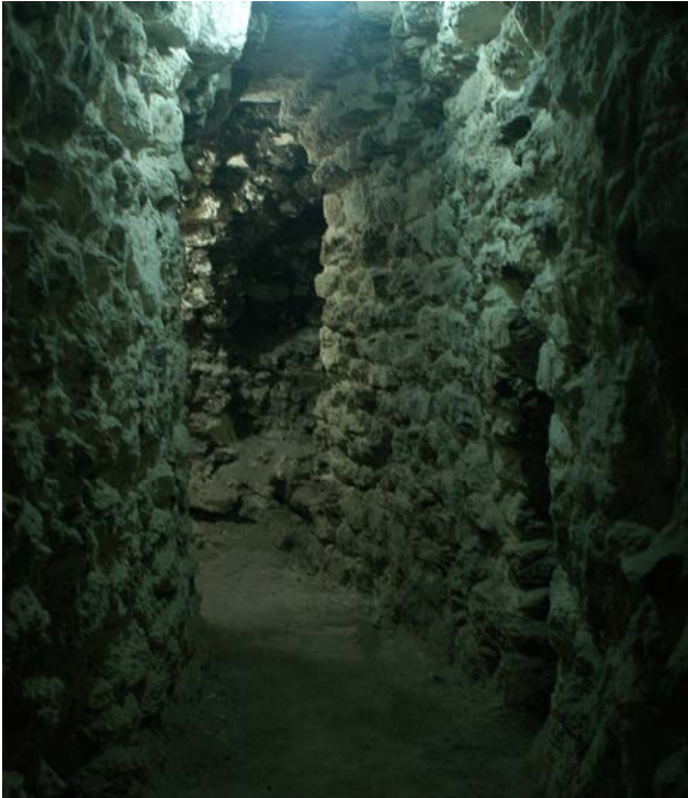
Fig.4. Consolidación del Túnel sureste exterior de Sub-1A.
