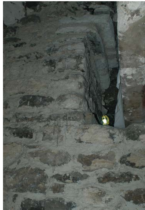
Fig.5 Estabilización del Friso exterior norte
