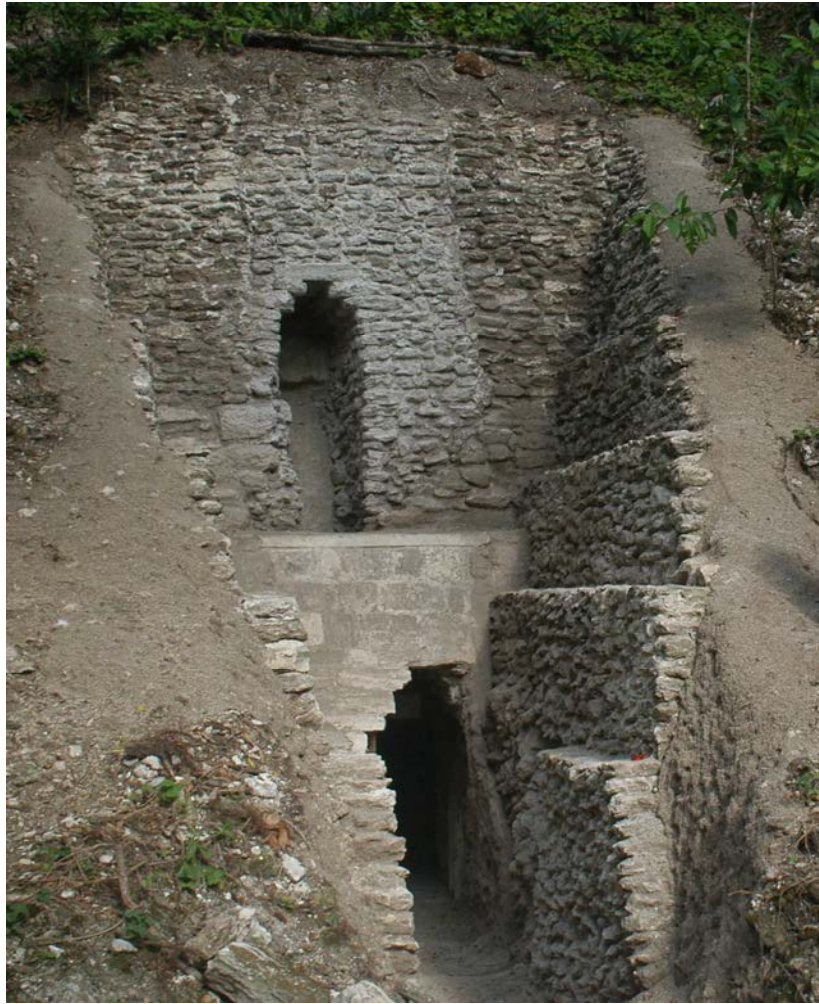
Fig.7 Acceso Principal, Entrada a Sub-1A.
