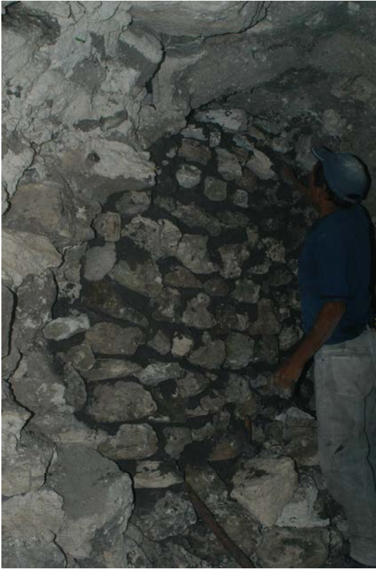
Fig.9. Relleno del túnel 69
