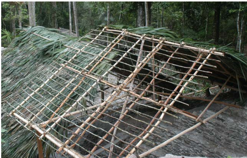
Fig.13 Elaboración del sistema de protección del túnel de entrada en la pirámide de las pinturas.
