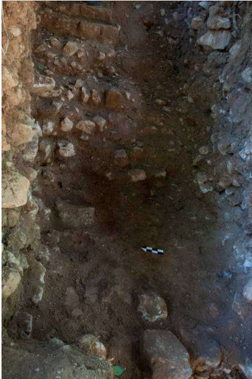
Figura 5.6 Parte de la escalinata deteriorada y parte de la Unidad CR32H-11 (Foto: C. Guirola)
