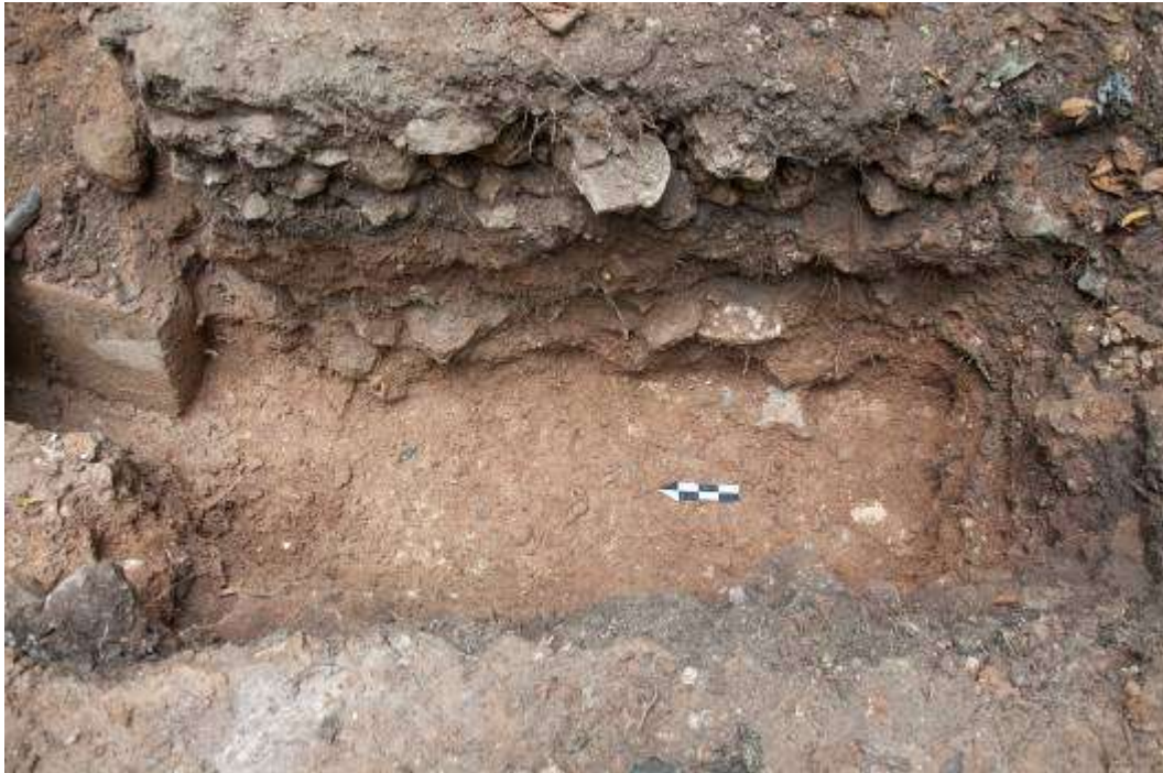
Figura 5.23 Piso de plaza deteriorado (Foto: C. Guirola)
