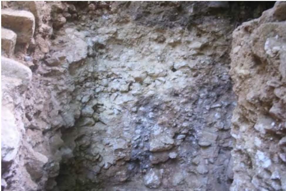
Figura 6.36 Detalle del relleno de la plataforma, perfil este de la unidad CR31B-10 (Fotografía por C. Álvarez)
