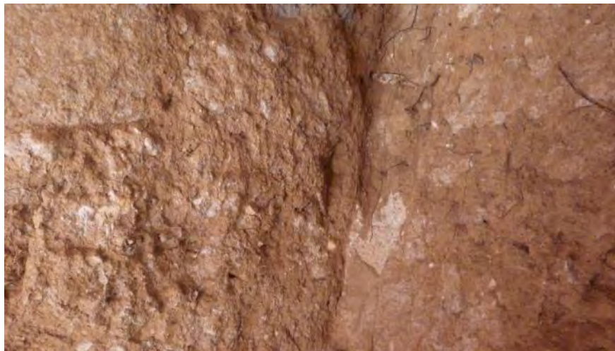
Figura 6.31 Esquina formada por el muro oeste del basamento (derecha) y la plataforma adosada (izquierda) Unidad CR31B-8 (Fotografía por C. Álvarez)
