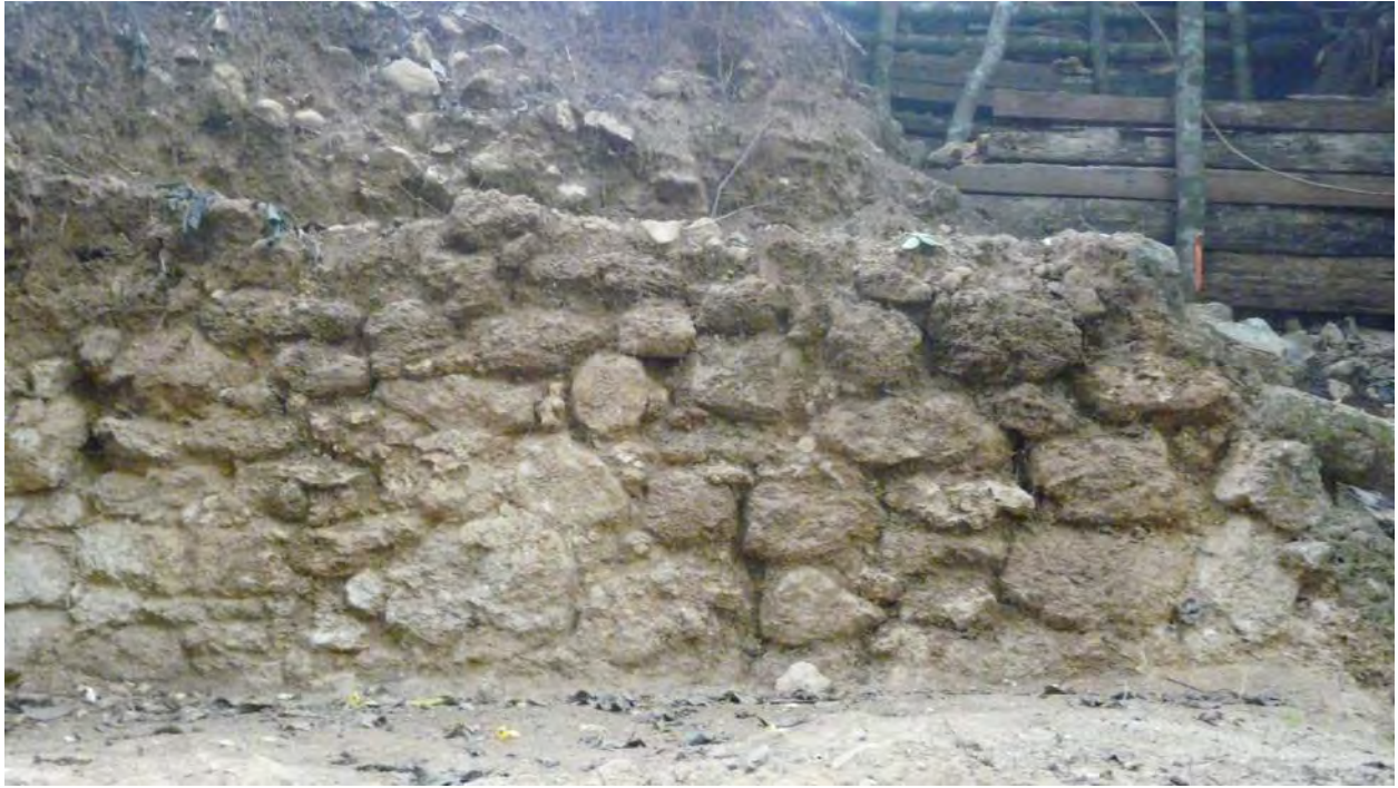
Figura 6.19 Muro del Cuerpo 3 del basamento de la Estructura 13Q-1. Perfil norte, unidad CR31B-5 (Fotografía por C. Álvarez)
