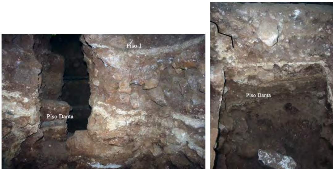
Figura 7.26. Detalle de perfiles de la unidad CR32H-19. Izquierda: detalle del perfil oeste, donde se observa el piso Danta cortado (registro en CR32D-74); Derecha: detalle del corte de gradas y referencia al piso Danta en el perfil sur (Fotos por E. Gómez)
