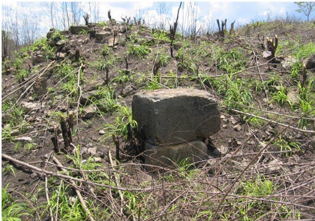
Figura 3.13: Columna o jamba de la estructura E1N1-13.
