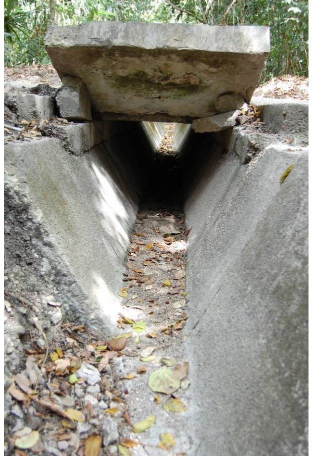
Lamina 1-2. Drenaje actual. L. Grazioso
