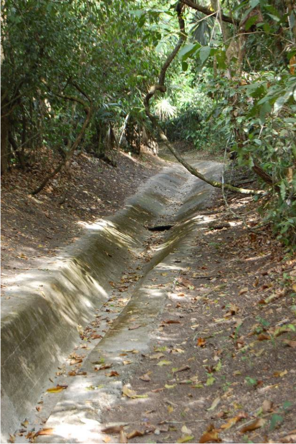
Lamina 1-1. Drenaje actual. L. Grazioso
