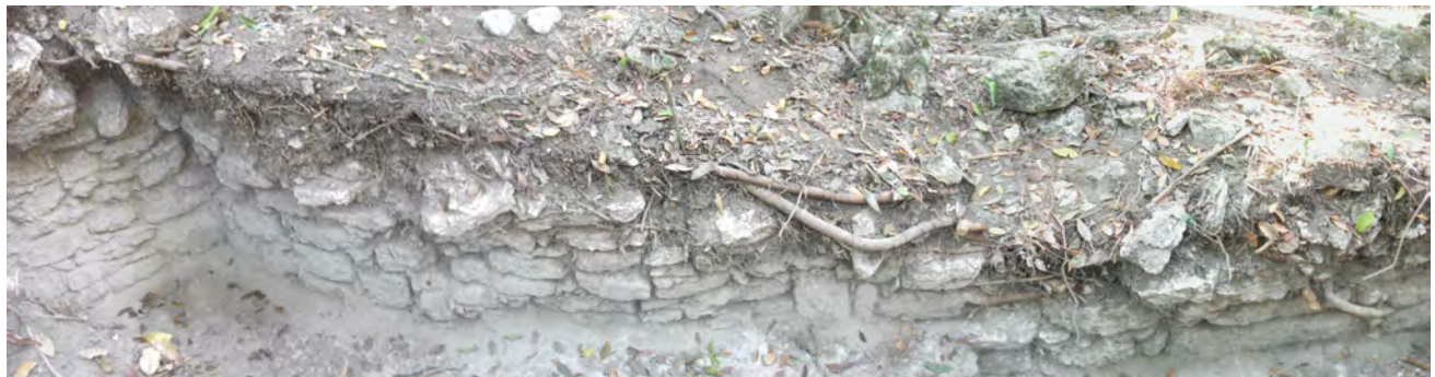
Figura 2.9.18. Unión del muro interno de parapeto Este, con Estructura 1213. (Fotografía M. Saravia, 2012).
