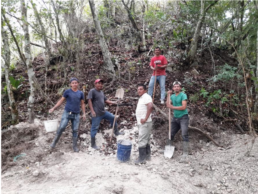
Figura 8.7. Nivelación del terreno y equipo de trabajo (E. Pérez, 2022).
