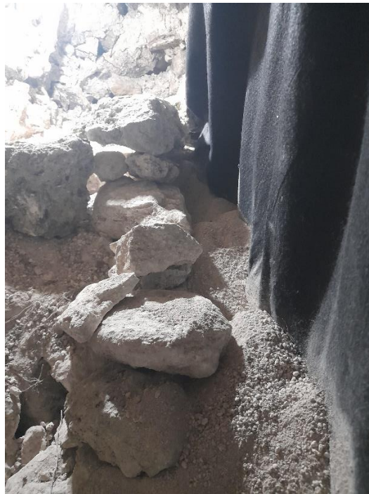
Figura 8.4. Geotextil, arena cernida y elevación de muro (E. Pérez, 2022).
