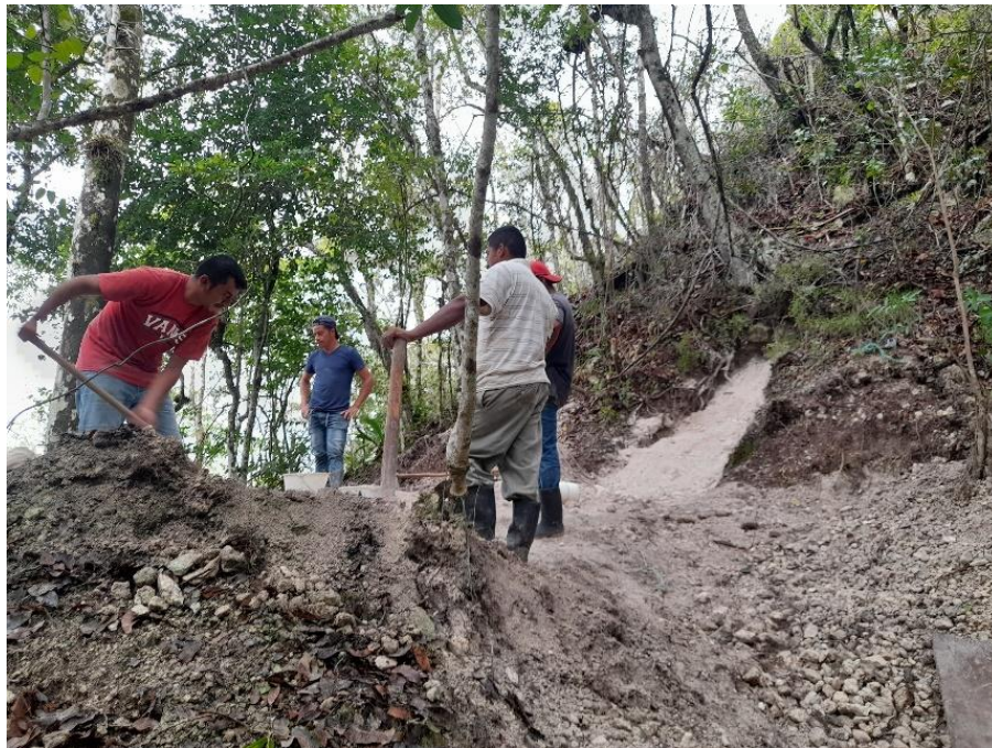
Figura 8.6. Cierre de ingreso del túnel, previo a nivelación (E. Pérez, 2022).
