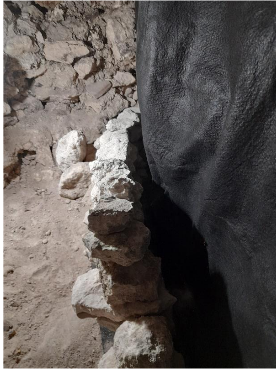
Figura 8.3. Muro protector colocado a 0.10 m del mascarón (E. Pérez, 2022).
