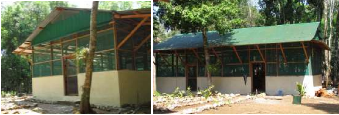
Figura 1.14 Edificios de oficina y bodega de materiales y herramientas, campamento PRALC (Foto por T. Barrientos).
