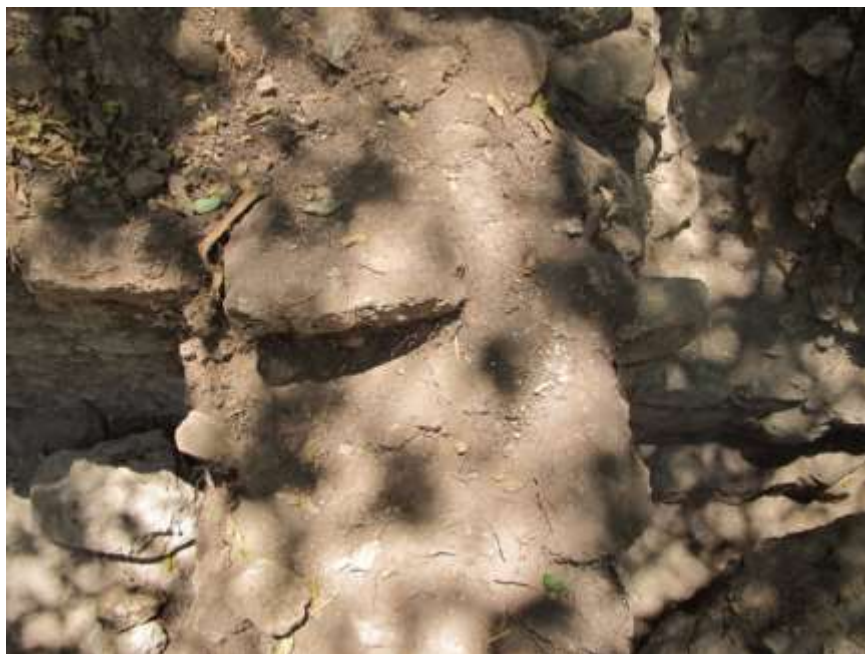
Figura 8.41. Muro sur del Cuarto 2 colocado sobre la fachada original del recinto de la estela. Notar que el muro original continúa a ambos lados del muro adosado (Fotografía L. Auld-Thomas).
