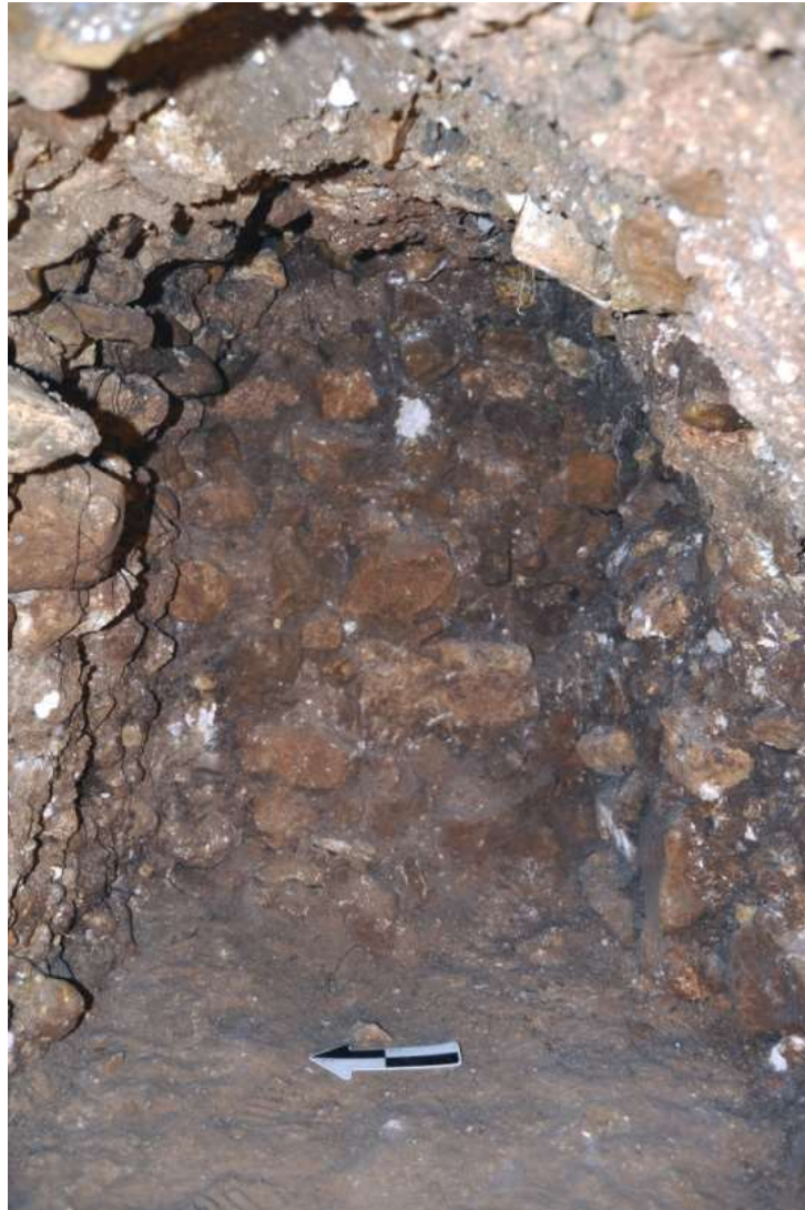
Figura 6.8 Muro de contención sobre la parte superior de la fachada identificada de 13Q-2-Sub 4 (Fotografía por E. Gómez).
