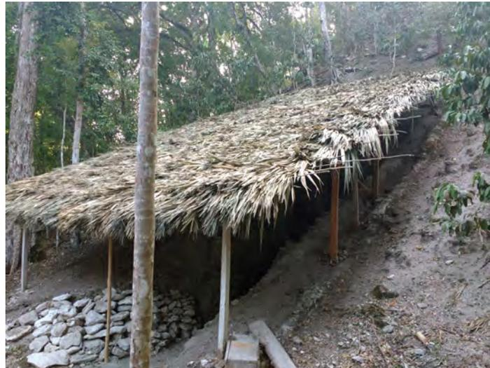
Figura 2.4. 7 Fotografía del nuevo techo del ingreso al túnel del cuarto de los murales (fotografía B. Beltrán)
