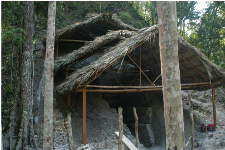
Figura 2.4. 4 Fotografía techo de protección en la entrada a los murales (fotografía L. Romero 2009)
